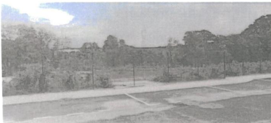
Bassin de rétention en partie Nord
